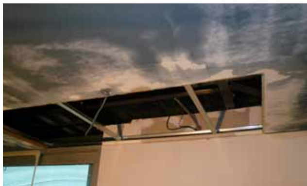
1. Beschadigde panelen verwijderen en omliggende zone schuren
