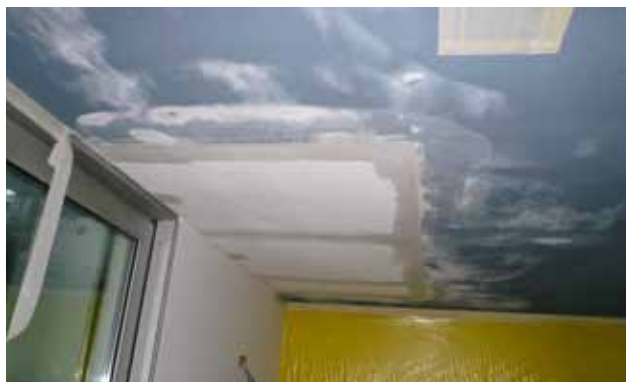
2. Nieuwe panelen installeren en randen opvullen
