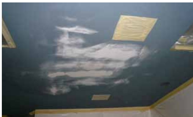
3. Droge voegen opschuren en pleister op de zone spuiten
