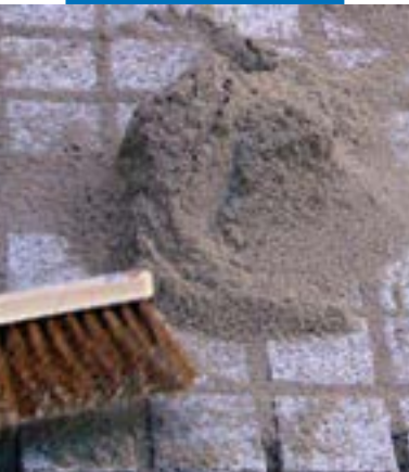
Reinigen van het afgevoegde oppervlak met een bezem
