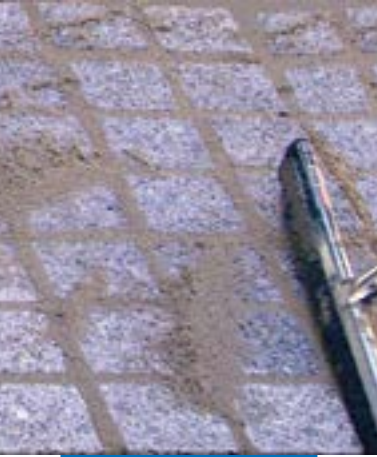
Aanbrengen met een vloertrekker
