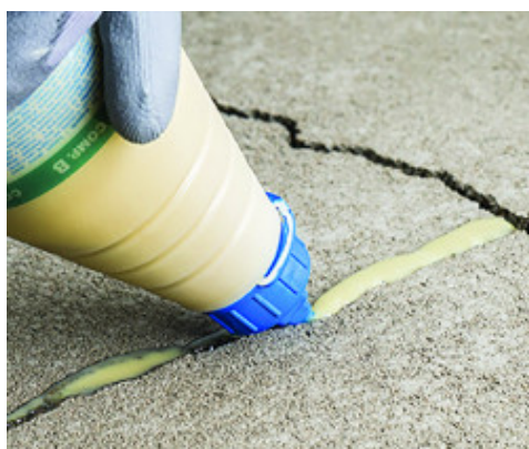
Giet het product in de scheur met behulp van het mondstuk
