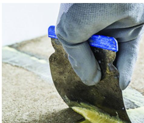
Verspreid het product gelijkmatig om de scheur te vullen
