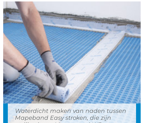
Aanbrengen van Mapeguard UM 35
