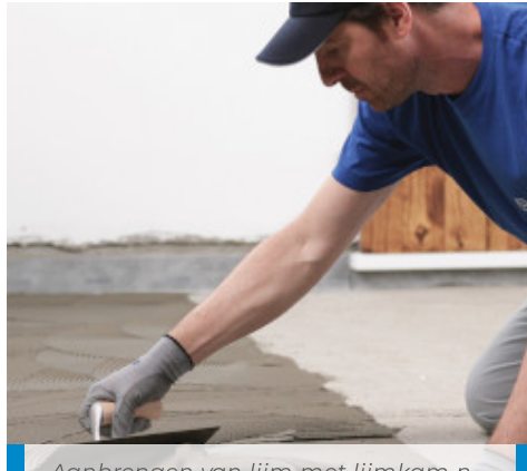
Aanbrengen van lijm met lijmkam n. 5
