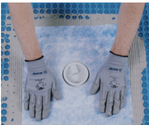
Waterdicht maken van afvoeren met Drain Vertical/Drain Lateral
