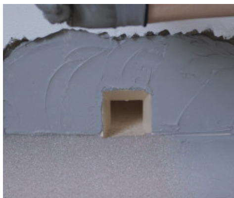
Waterdicht maken van afvoeren met Drain Front
