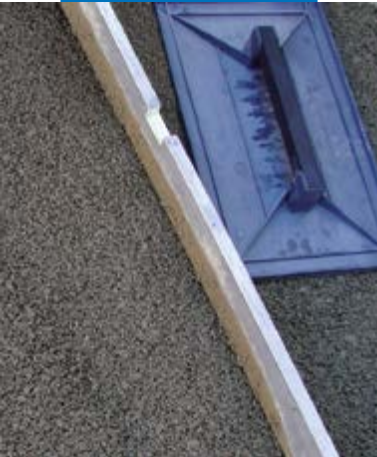
Afreien van de Mapedrain Monokorn-mortel
