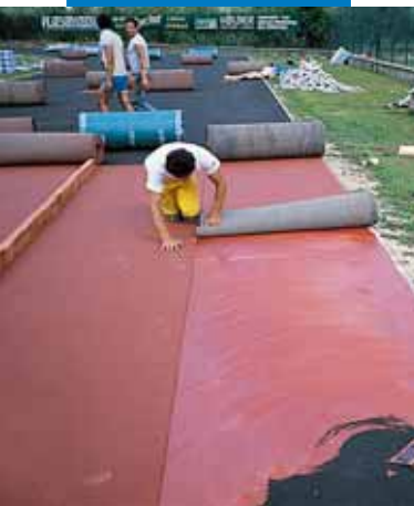
Aanbrengen van een rubber sportvloer met Adesilex G19
