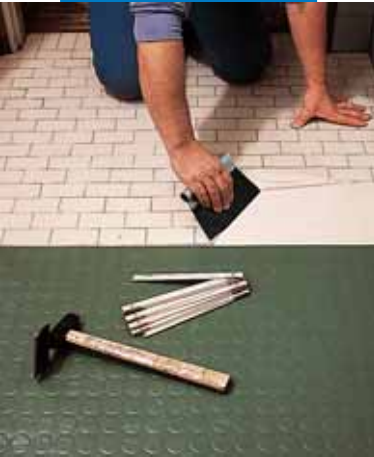
Met een getande lijmkam aanbrengen van Adesilex G19
