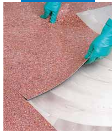
Aanbrengen van PVC-vloerbedekking met Adesilex G19
