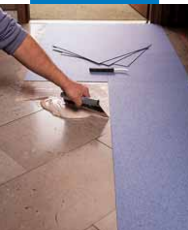
Het met Adesilex G19 aanbrengen van PVC op een niet-zuigende ondergrond
