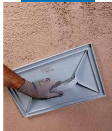
Flak afwerken van Mape-Antique CC
