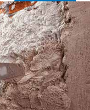
Aanbrengen van Mape-Antique CC op Mape-Antique Rinzafo
