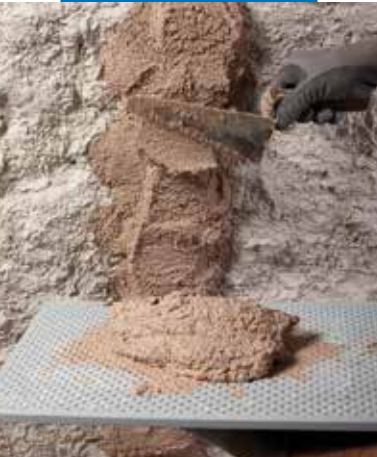
Aanbrengen van niveaulagen
