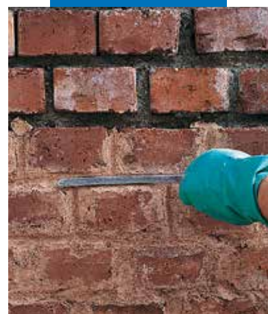
Afwerken van met Mape-Antique CC opgevulde voegen
