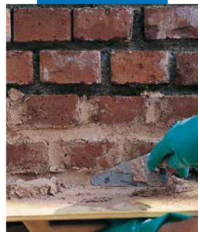
Opnieuw afvoegen van bakstenen met Mape-Antique CC
