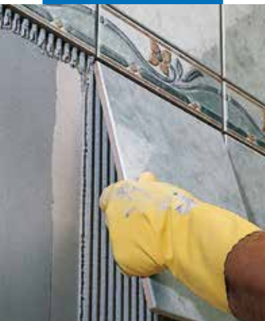
Betegelen van wanden van gipskartonplaat met enkelgebakken tegels
