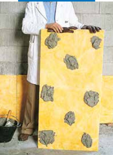
Verlijmen van isolatieplaten op onbewerkte muren
