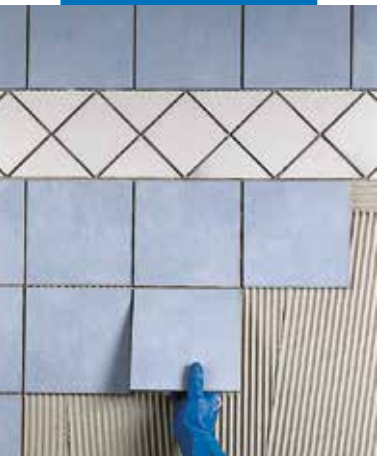
Betegelen van gepleisterde badwanden met enkelgebakken tegels
