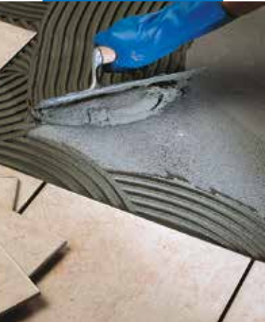
Betegelen met enkelgebakken vloertegels
