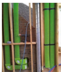
Uitbreiding woning Schipluiden
