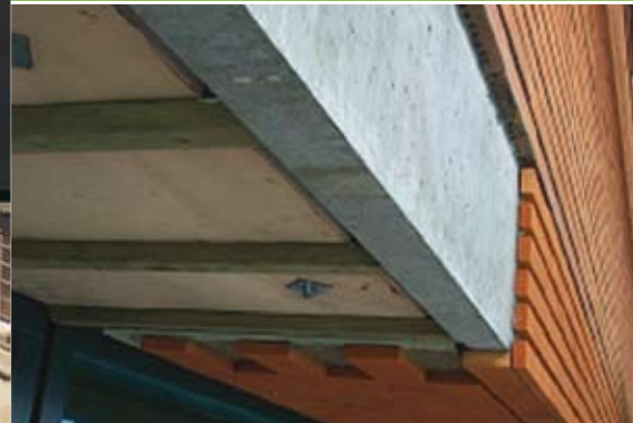
ETER-BACKER HD: draagplaat voor steenstrips
