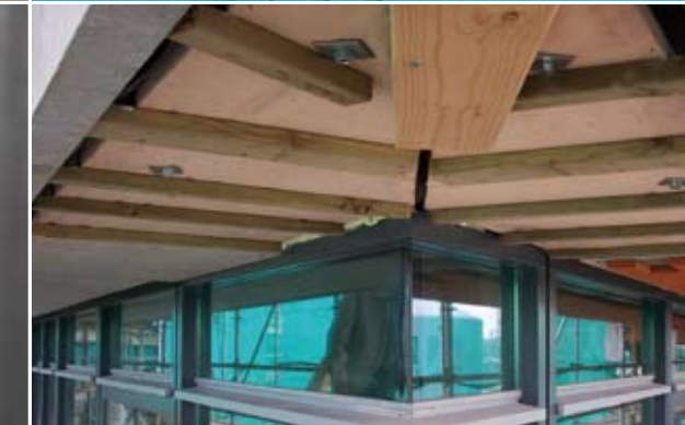
BLUCLAD: draagplaat voor sierpleister
