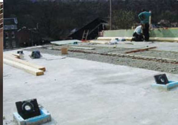
ETER-BOARD HD: verloren bekisting
