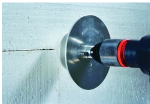
Plug indraaien met hulpstuk
